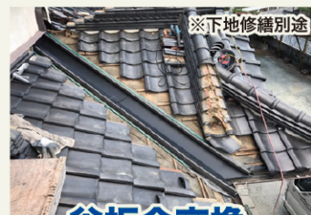
※下地修繕別途 谷板金交換
