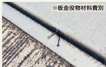
※板金役物材料費別 屋根外壁釘打ち修理
