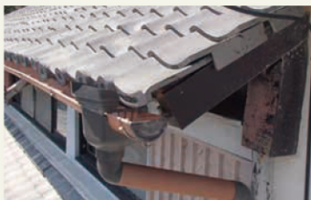
雨樋交換 (105半丸)
