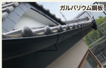
ガルバリウム鋼板 破風板板金巻き (幅:180mm)
