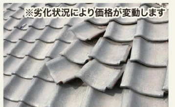
※劣化状況により価格が変動します 瓦ズレ直し
