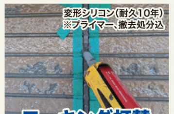
変形シリコン (耐久10年) ※プライマー、撤去処分込 コーキング打替
