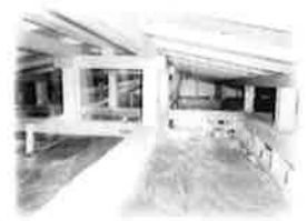
屋根裏にも断熱材を入れて います。
