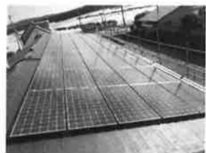
パナソニック(株)製 太陽光発電システム 12.2kwを屋根に設置させて いただきました。
