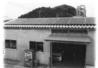
屋根に設置した太陽光発電パネル
