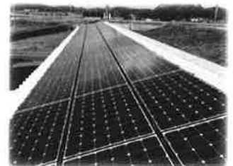
沢山のパネルを設置して頂きました
