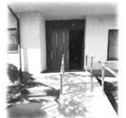
新しくなった玄関ドアとスロープです。
