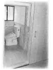
バリアフリーに改修させて頂いたトイレです。
