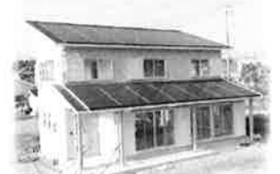
屋根には15kwの太陽光発電パネルです。
