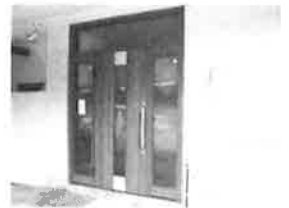
工事後：玄関ドア
